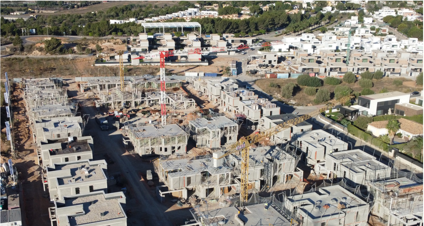
54 VIVIENDAS UNIFAMILIARES EN TORRECONIL. BOSCO HOMES.
