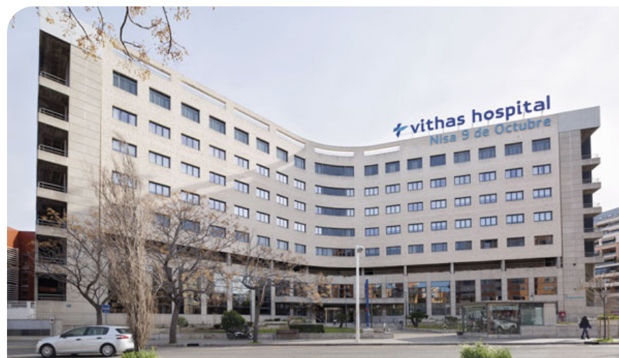
Consultas Externas, Unidad de Otorrino, Pediatria y Urgencias, Hospital 9 de Octubre, Valencia.
